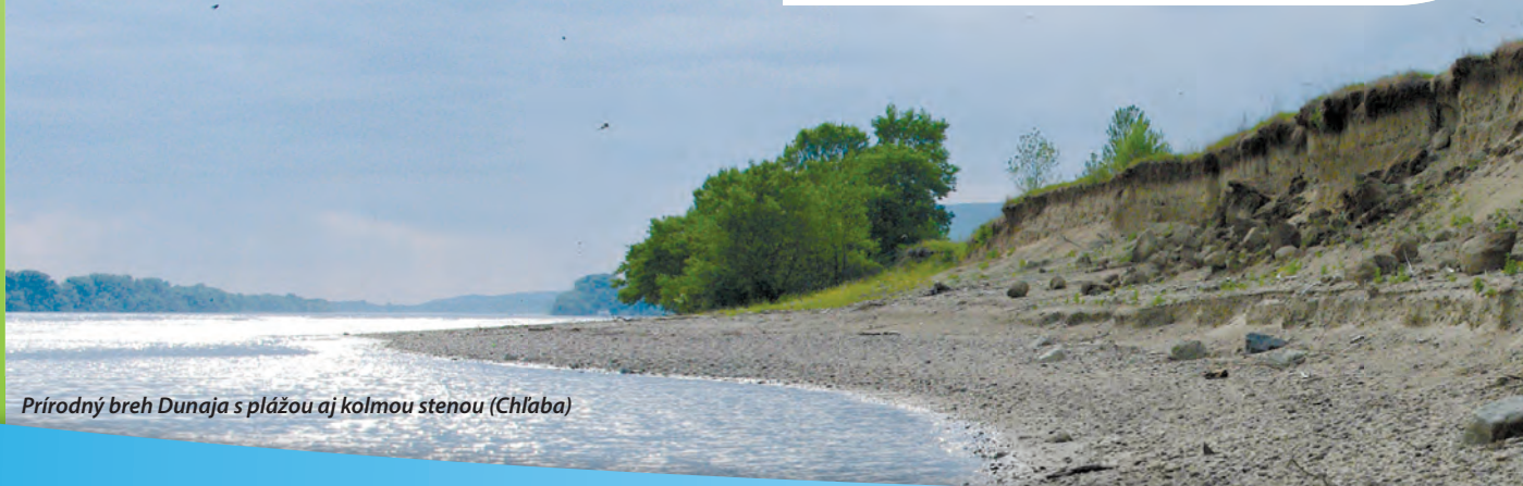
Obnova prirodzeného brehu (Zlatná na Ostrove)
