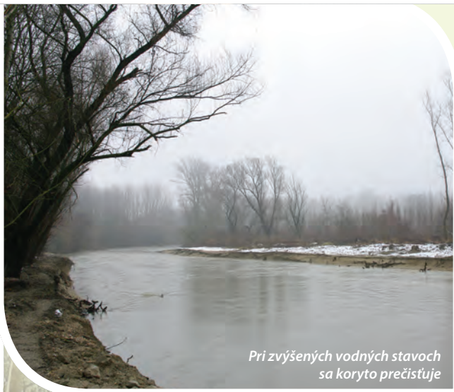
Obnova vtoku do Medvedovského ramena
