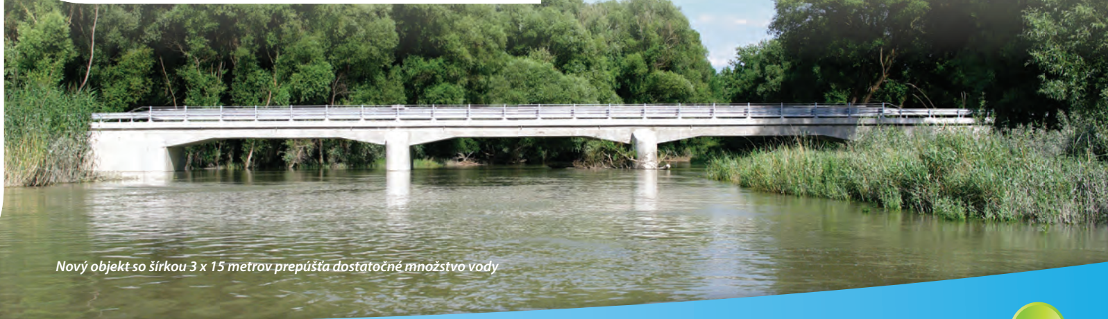
Bývalý priepust cez rameno mal šírku 2 x 2 metre
